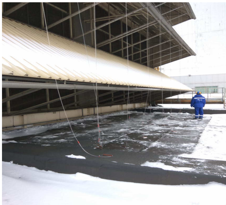
Рис. 2.59. Очистка защитных сеток от птиц и мусора КВОУ стряхиванием
