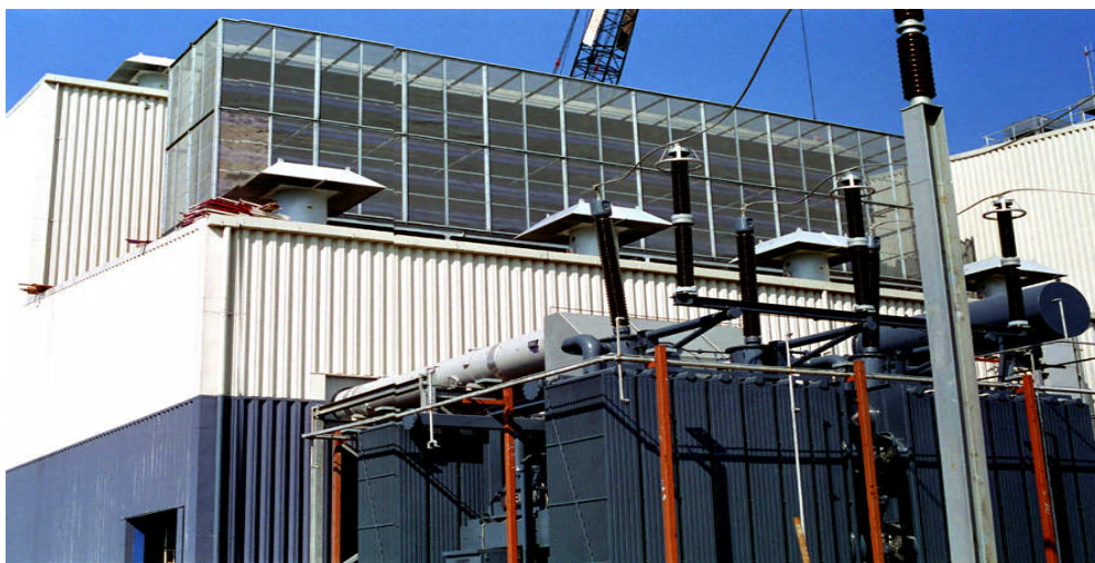
Рис. 2.31. Противомоскитная сетка на ТЭЦ ГТУ в Бангкоке (Таиланд)[9]
