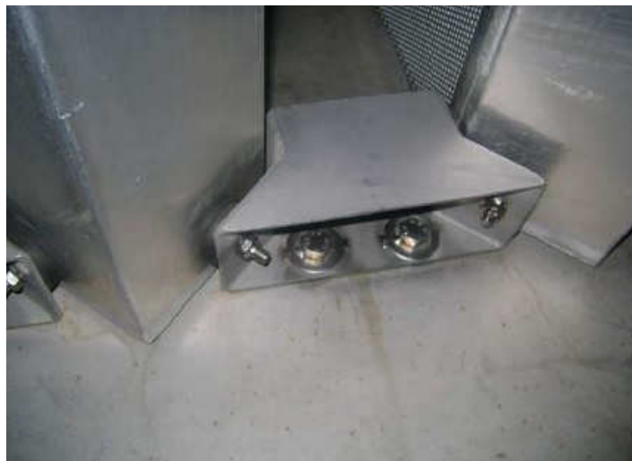
Рис. 3.31. Крепление пластин глушителя шума
