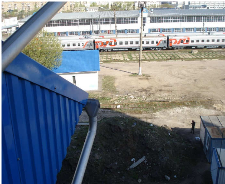
Рис. 5.8. Всас КВОУ ГТУ ориентирован на железнодорожный вокзал
