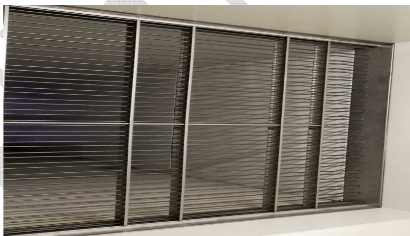
Рис. 2.81. Электрическая АОС в КБОУ ГТУ Siemens SGT-300
