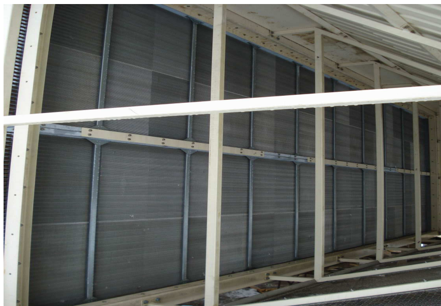
Рис. 2.75. Теплообменный аппарат в КБОУ ГТУ
