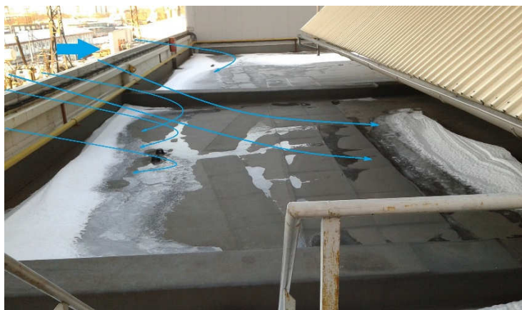
Рис. 5.29. Линии тока основного потока и подветренного вихря
