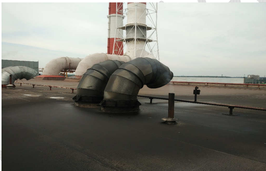
Рис. 5.40. Выпары эксгаустера и промасленная крыша машинного зала
