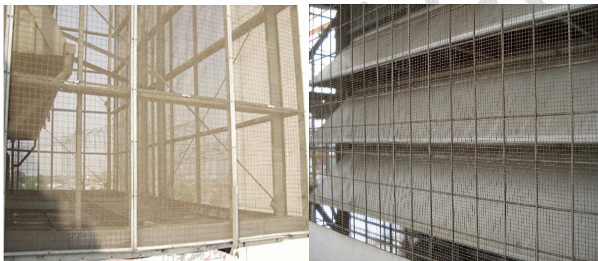
Рис. 2.32. Защитная сетка перед КВОУ ГТУ: а) в Бангладеш [9]; б) на ТЭЦ ГСР Энерго
