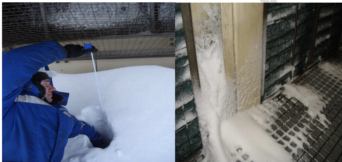
Рис. 5.30. Формирование подветренным вихрем снежного заноса: а) перед КВОУ; б) на фильтрах первой ступени
