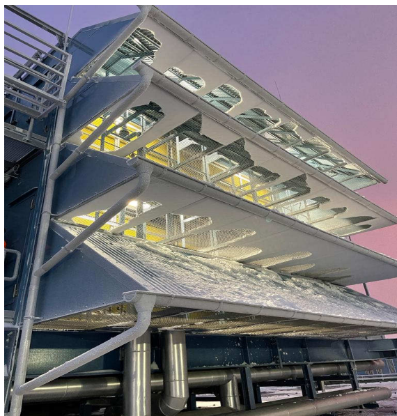
Рис. 2.51. Очистка защитных сеток от птиц на КВОУ ГТУ НКХК
