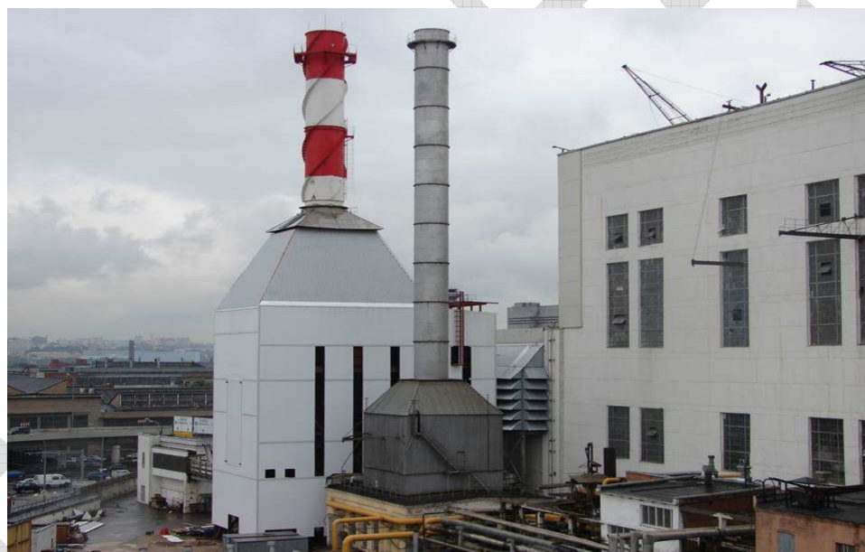
Рис. 5.1. КВОУ ГТУ ТЭЦ-1 в ЮАО перед стеной котла-утилизатора
