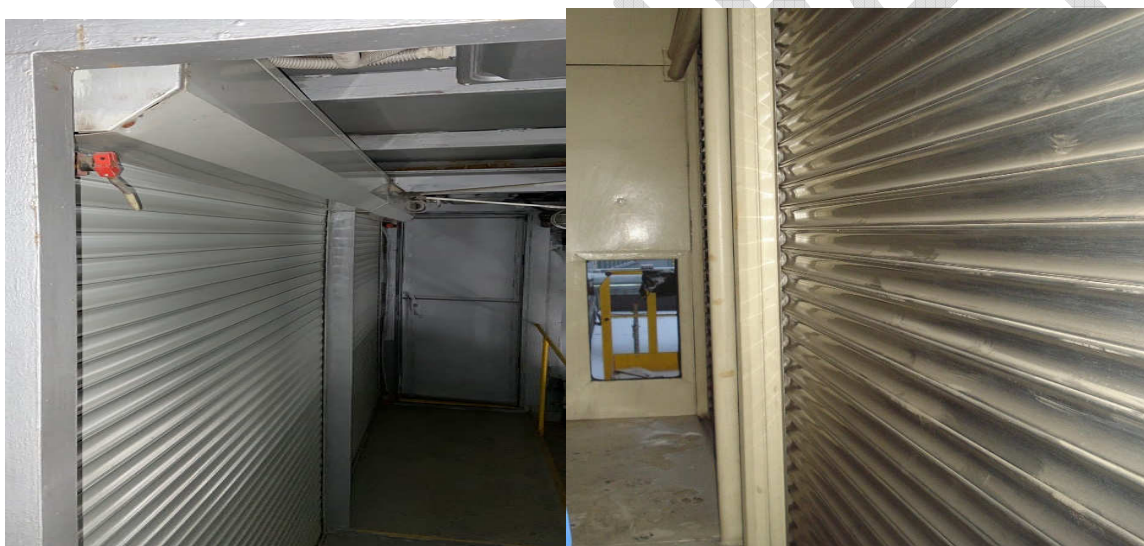
Рис. 3.42. Устройства, предотвращающие поступление влажного и загрязненного атмосферного воздуха в КВОУ и ГТУ: а) роллеты; б) воздушная заслонка
