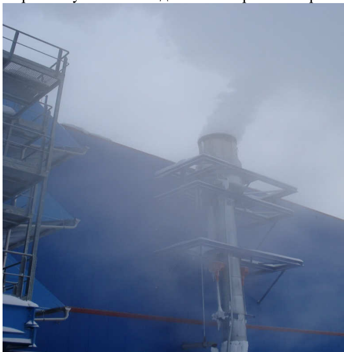
Рис. 2.48. Влажный пар из расширительных дренажей паровой турбины [14]
