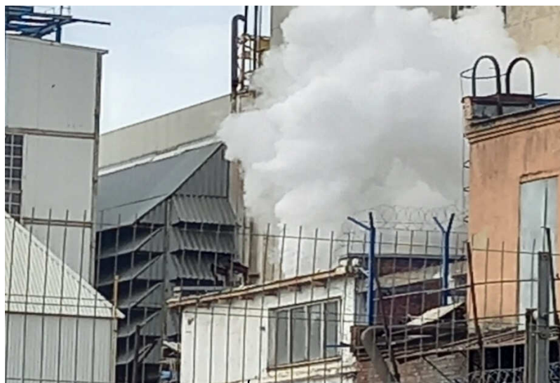
Рис. 2.56. Выпары барботера на всасе КБОУ ГТУ Ansaldo AE64.3A
