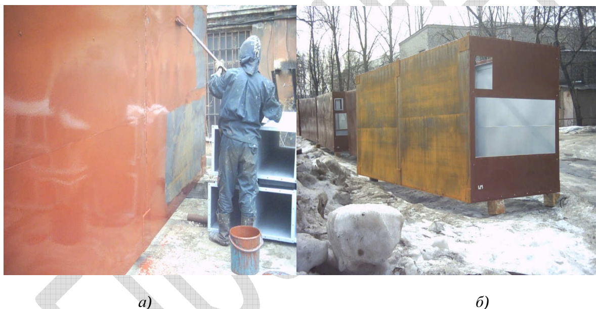
Рис. 1.14. Окраска модулей КВОУ: а) по неподготовленному металлу; б) после окраски
