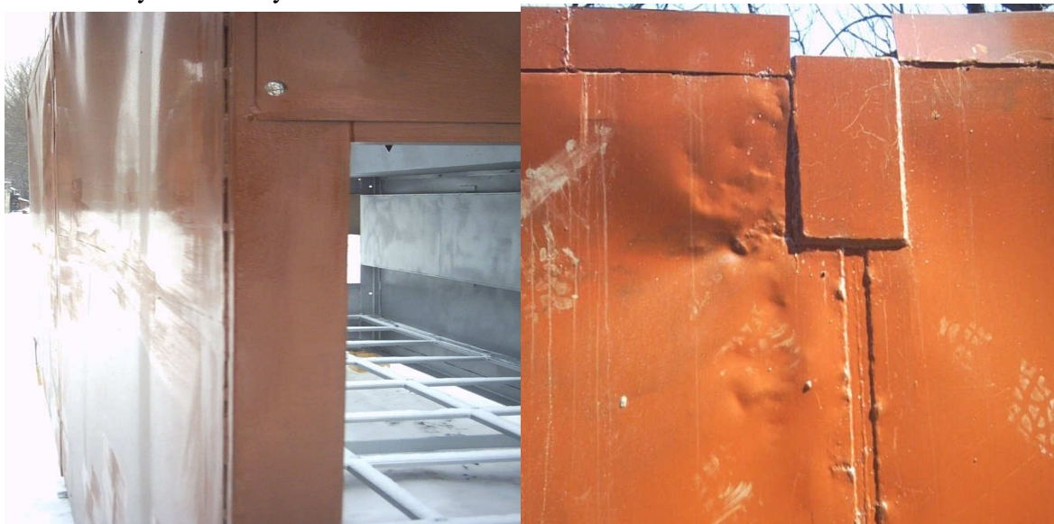
Рис. 1.12. Модуль КБОУ: а) перекрытие листом металла толщиной 2 мм; б) прожиг металла
