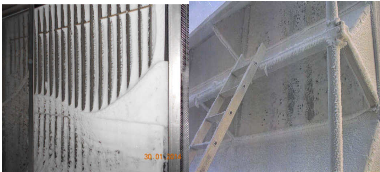
Рис. 2.39. Последствия использования противомоскитных сеток зимой: а) скопление снега между противомоскитной сеткой и фильтром; б) обмерзание и блокирование противомоскитных сеток и всаса КВОУ [10]
