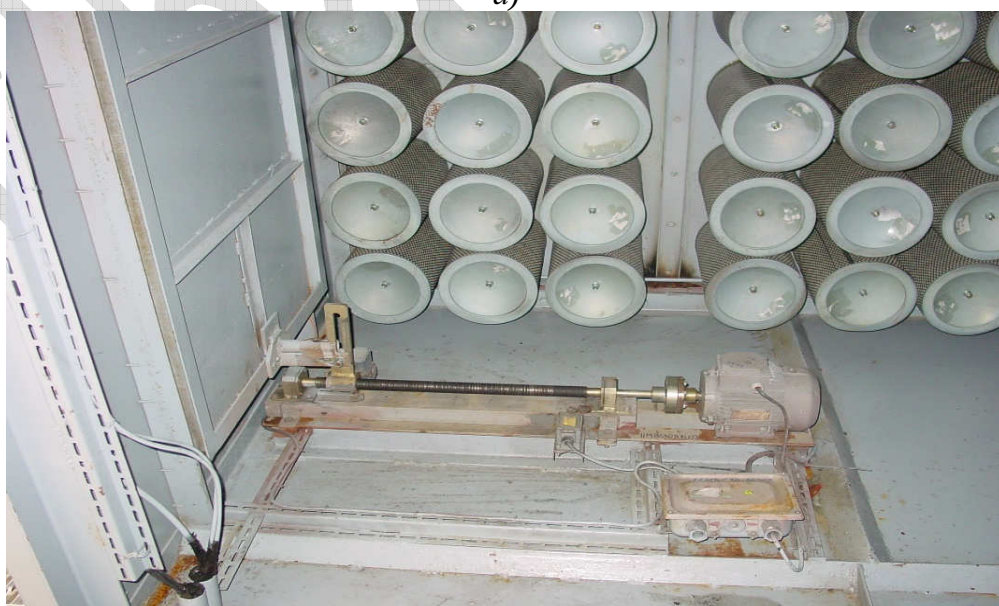
Рис. 1.4. Блок фильтров тонкой очистки: а) подвод воздуха к ФТО; б) ФТО и привод байпасных клапанов
