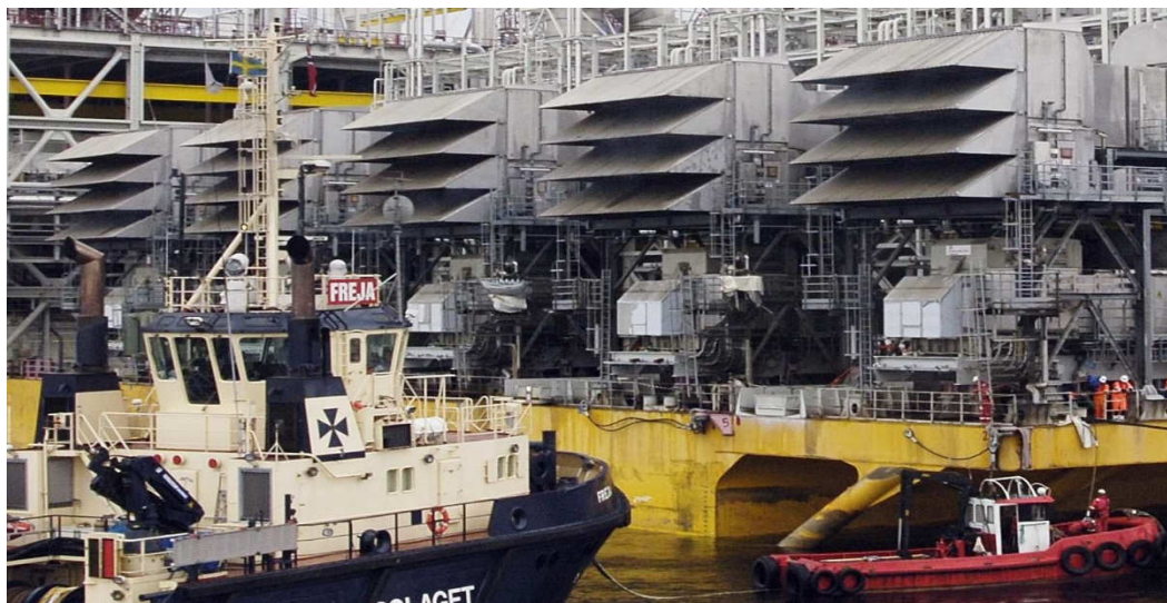
Рис. 2.25. КБОУ ГТУ LM6000 со снеговыми погодными козырьками
