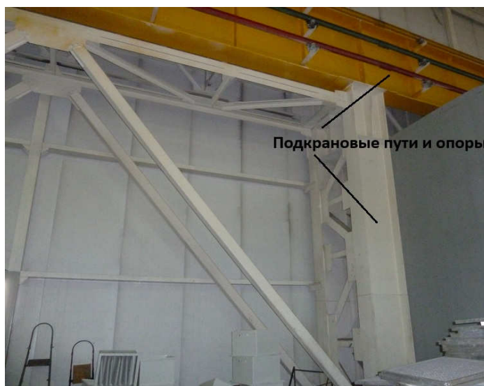
Рис. 5.31. Подкрановые пути и опоры в машинном зале
